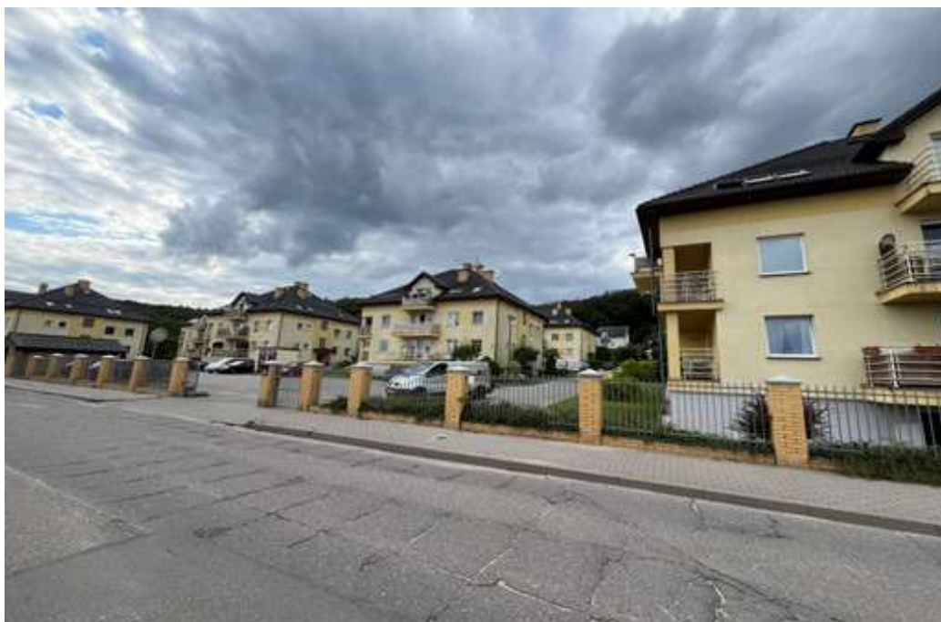
Fot. 8. Wielorodzinna zabudowa mieszkaniowa na osiedlu Rekowo Dolne przy ul. Polnej (fot. Małgorzata Bidłasik)
