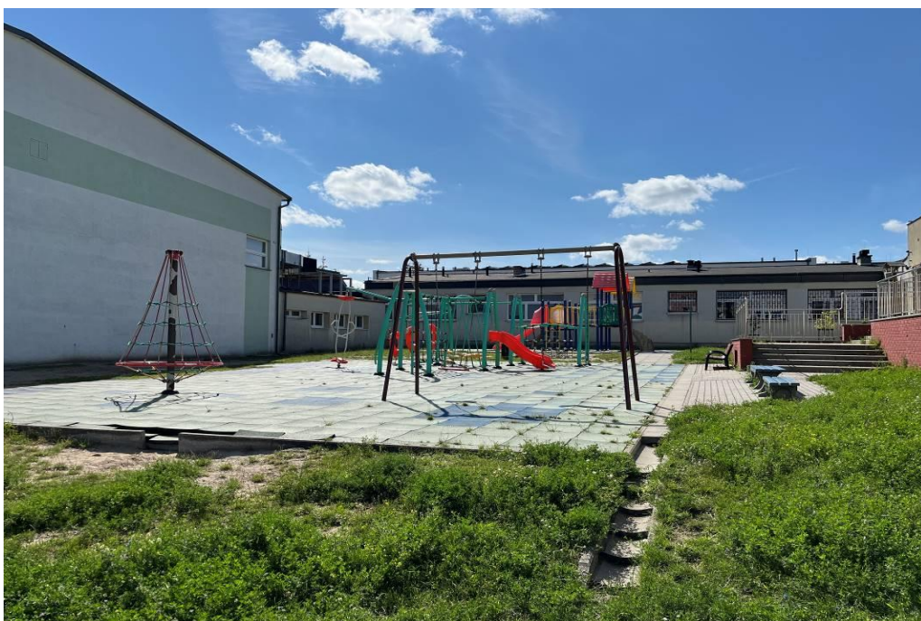
Fot. 27. Część podwórka Zespołu Szkolno-Przedszkolnego nr 2 z niezagospodarowaną zielenią i brakiem zacienienia (fot. Małgorzata Bidłasik)
