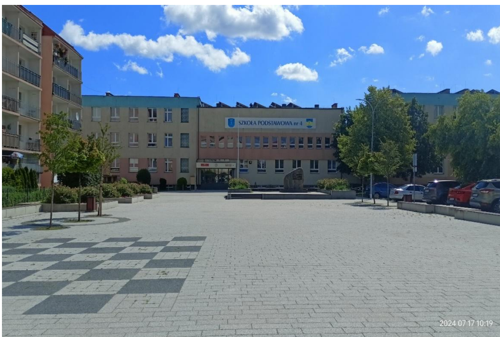
Fot. 25. Plac z nawierzchnią z kostki brukowej przed Szkołą Podstawową nr 4 (fot. Natalia Horak)
