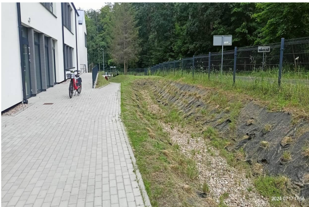
Fot. 24. Rów infiltracyjny przy Szkole Podstawowej nr 5 (fot. Natalia Horak)
