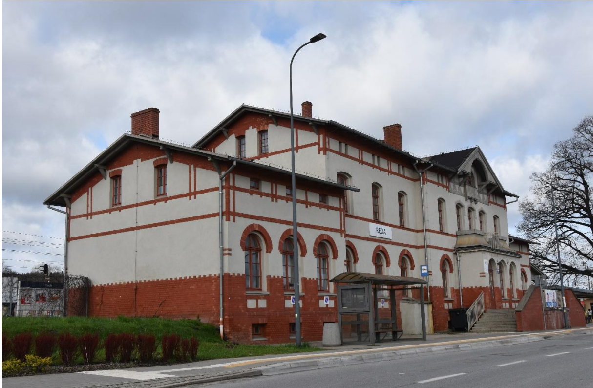
Fot. 4. Reda. Budynek dworca, ul. Gdańska 72 (fot. autor opracowania).
