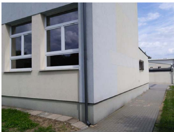
Fot.6 Widok elewacji szczytowej od strony południowej
