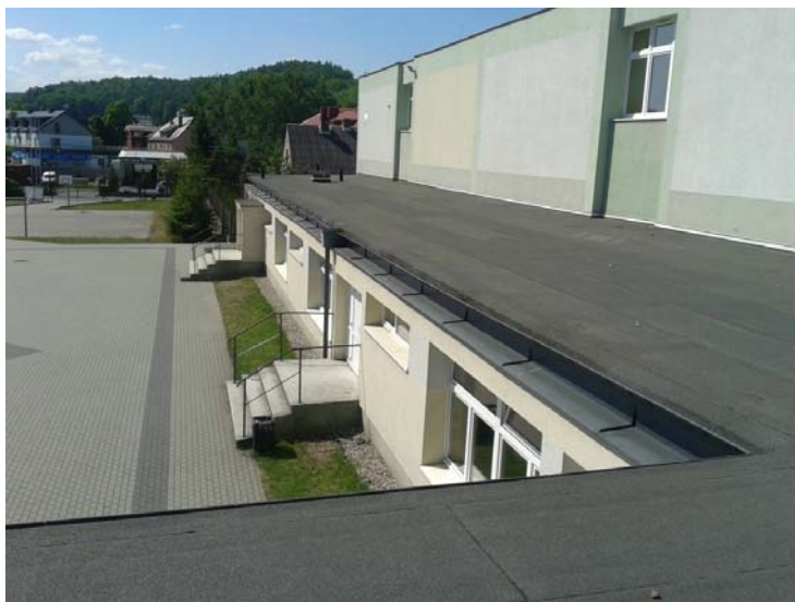
Fot.4 Widok elewacji wschodniej z poziomu dachu części jednokondygnacyjnej
