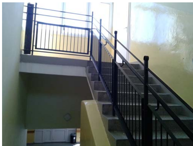
Fot.13 Klatka schodowa – drugie ujęcie
