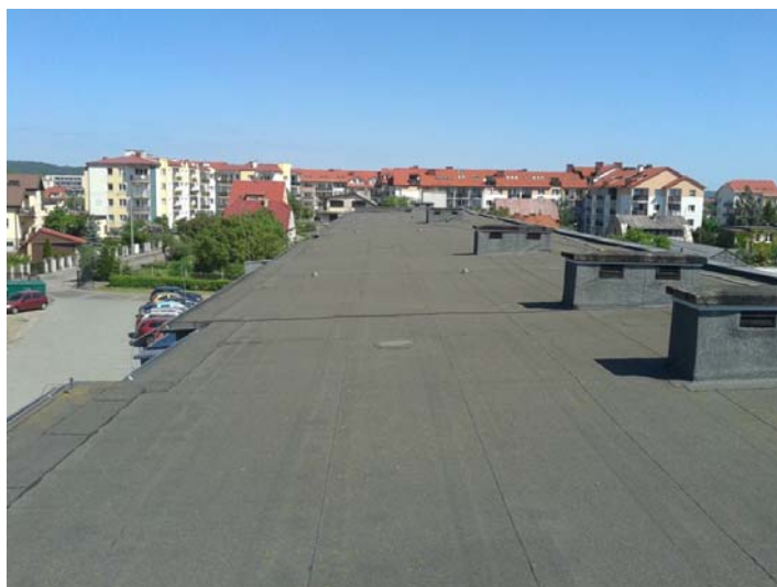
Fot.8 Widok dachu części dwukondygnacyjnej
