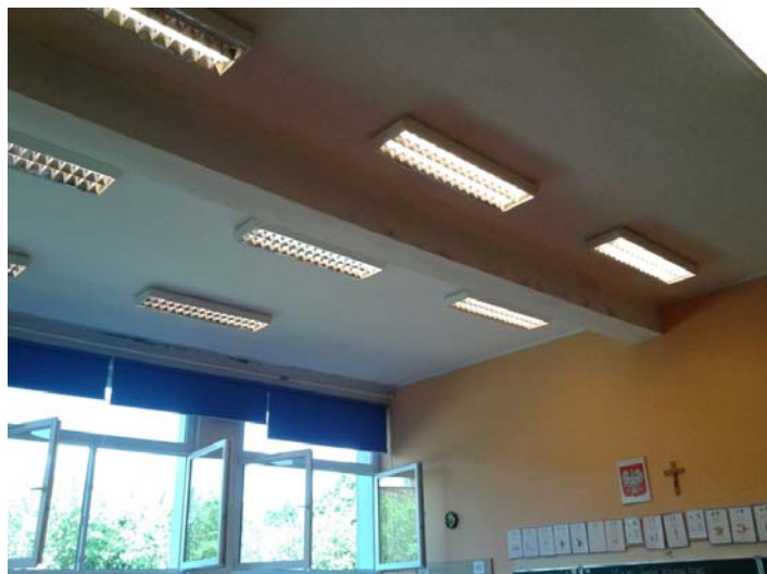
Fot.10 Widok konstrukcji stropu nad parterem części dwukondygnacyjnej
