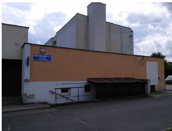
Fot.5 Widok elewacji szczytowej od strony północnej
