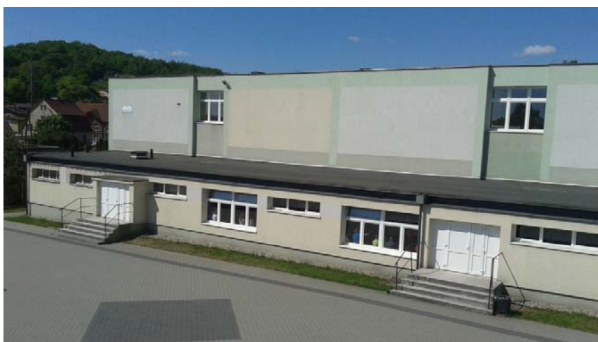
Fot.2 Widok elewacji wschodniej (widok od strony patia)
