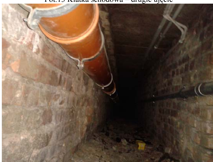
Fot.14 Widok kanału podposadzkowego – ścianki murowane, płyta wierzchnia żelbetowa
