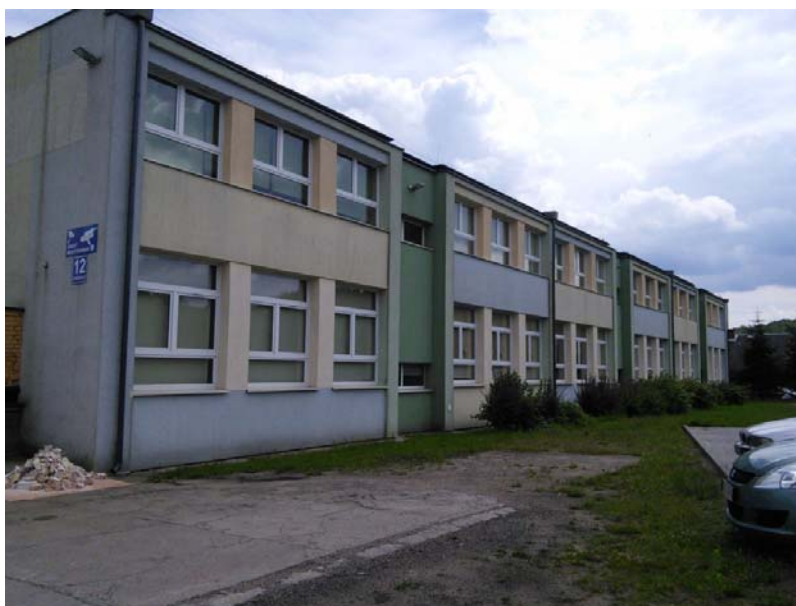
Fot.1 Widok elewacji zachodniej (widok od strony parkingu)
