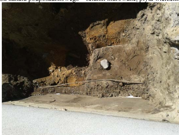
Fot.15 Odkrywka stopy fundamentowej pod ścianą szczytową południową
