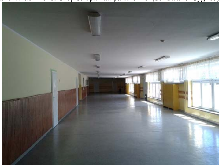
Fot.11 Widok korytarza części jednokondygnacyjnej – płyty kanałowe stropodachu ułożone ze spadkiem
