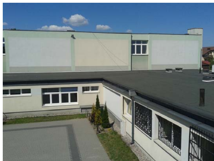
Fot.3 Widok elewacji wschodniej (widok od strony patia)
