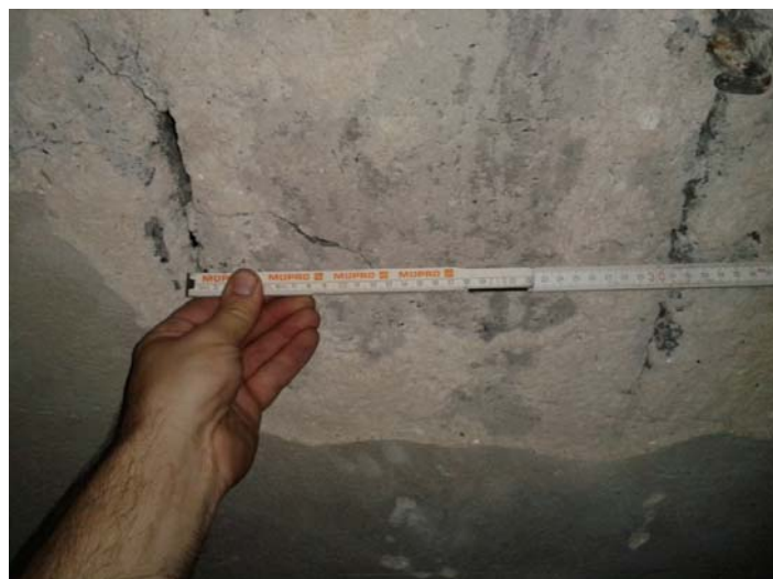
Fot.16 Strop z elementów prefabrykowanych nad piwnicą
