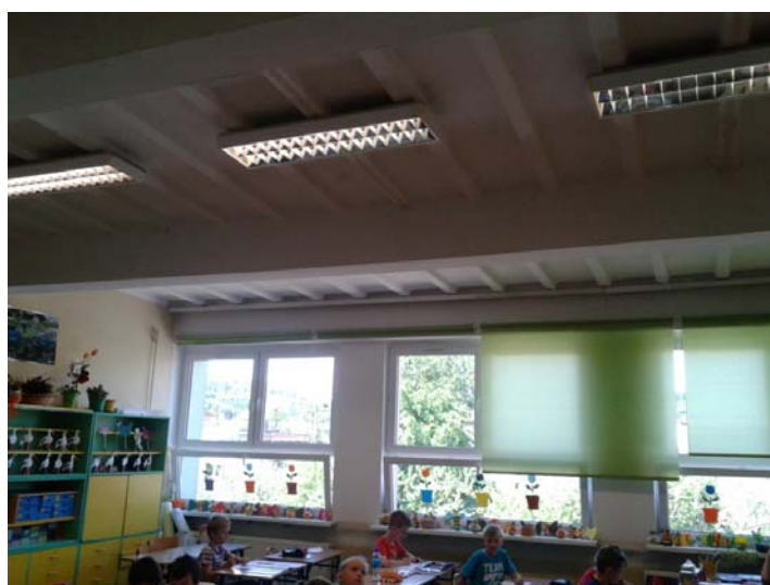
Fot.9 Widok konstrukcji stropodachu części dwukondygnacyjnej (płyty dachowe korytkowe oparte na żebrach)
