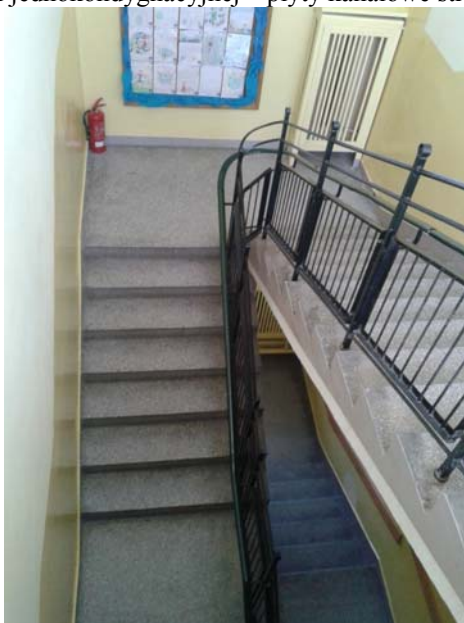
Fot.12 Klatka schodowa (biegi, podest żelbetowy monolityczny wykończone lastricem)
