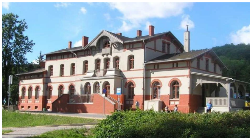
Fot. 5. Reda, dworzec kolejowy (foto źródło: Gminna Ewidencja Zabytków).
