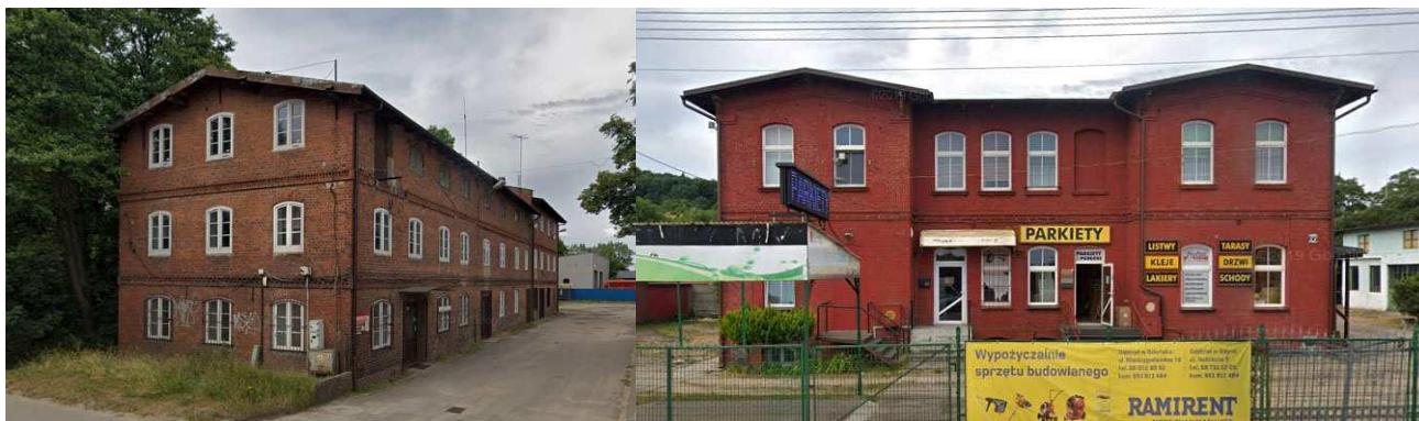
Fot. 6. Reda, spichlerz w zespole produkcyjnym przy ul. Puckiej 9 oraz budynek dawnej mleczarni przy ul. Gdańskiej 6 (foto źródło: Gminna Ewidencja Zabytków).
