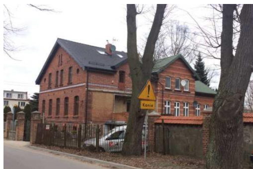
Fot. 3. Reda - Pieleaszewo, budynek dawnego dworu (foto źródło: Gminna Ewidencja Zabytków).
