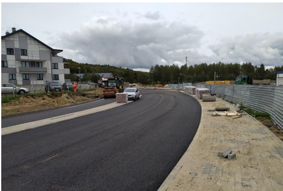
ulica Handlowa w budowie
