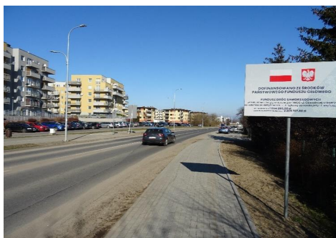
ulica Obwodowa po przebudowie
