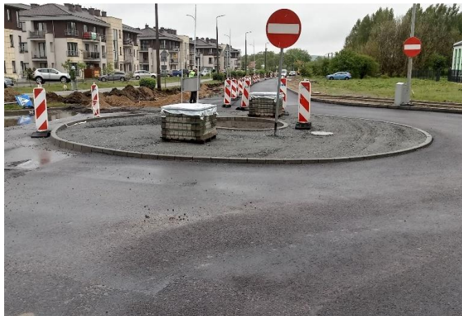
Rondo przy ul. Olimpijskiej w budowie
